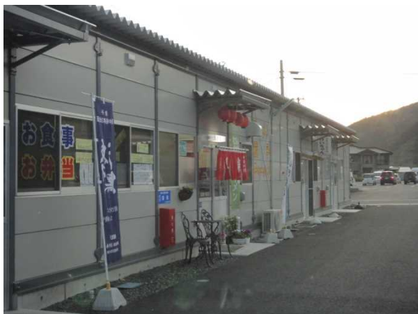
釜石市鵜住居地区 仮設商店
