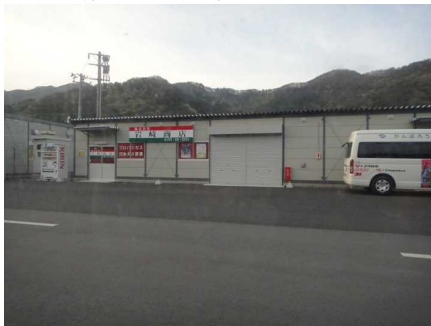
釜石市鵜住居地区 仮設商店
