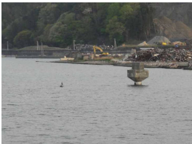
大槌町 大槌川河口 JR 山田線橋脚
