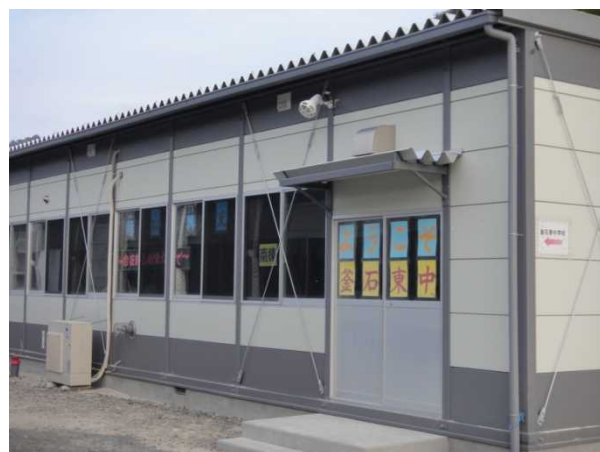
釜石東中学校 仮設校舎
