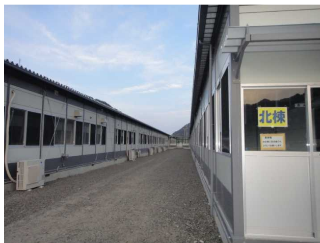
釜石東中学校 仮設校舎
